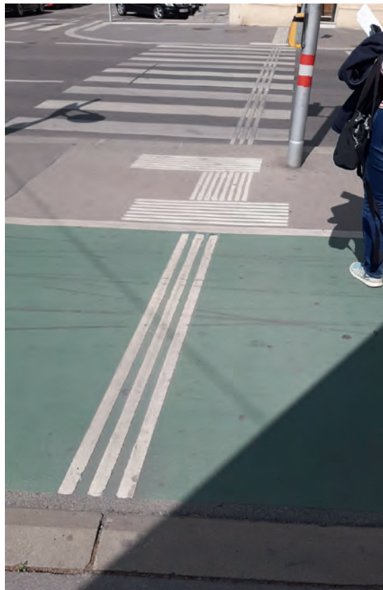
1010 Wien, Kreuzung Nibelungengasse/Operngasse: Kein Zebrastreifen, Blindenleitweg kreuzt Radweg.
